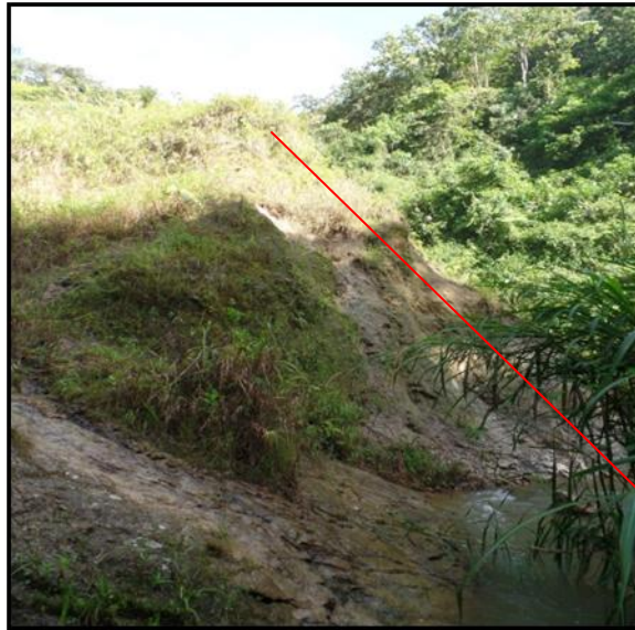
Foto 7. Socavación en las paredes de los taludes
